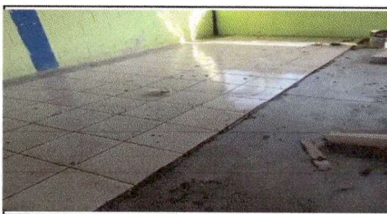
FOTO 6: Sustitución de piso de cemento liquido piso ceramico
