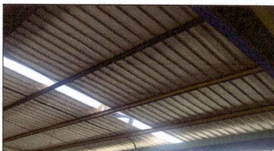
FOTO 4: Sustitución de lámina, por lámina troquelada aluzinc calibre 25
