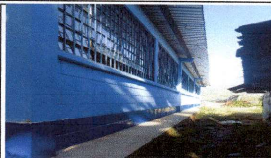
FOTO 8: Pintura en muros exteriores e interiores
