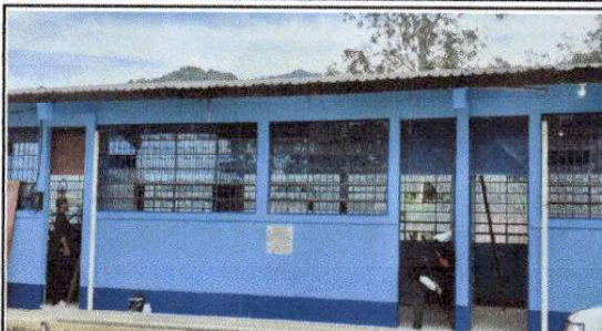
FOTO 7: Sustitución de canal de metal
