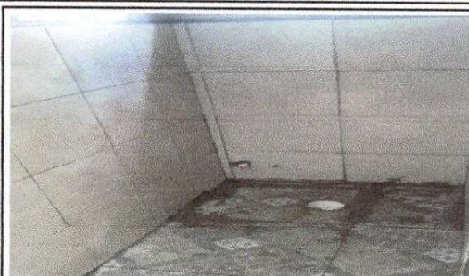
FOTO 2: Sustitución de piso de cemento liquido por piso ceramico Y Sustitucion de Azulejo EN BAÑOS
