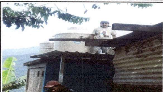
FOTO 1: Sustitución de lámina, por lámina troquelada aluzinc calibre 26 Y Sustitución de estructura de soporte por metal EN BAÑOS
