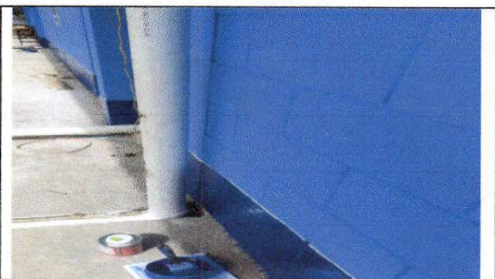
FOTO 11: Pintura en muros exteriores e interiores
